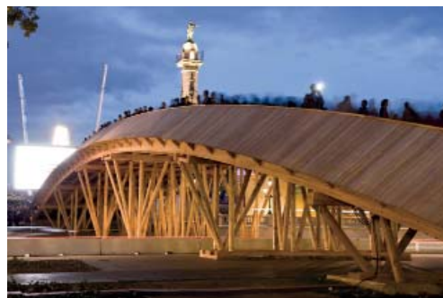
La passerelle de l'architecte Kawamata reliant les Quinconces et les quais à Bordeaux a été réalisée avec une colle polyuréthane Everad
