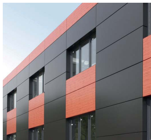
Les colles polyuréthane Everad collent de manière durable les panneaux de bardage.
