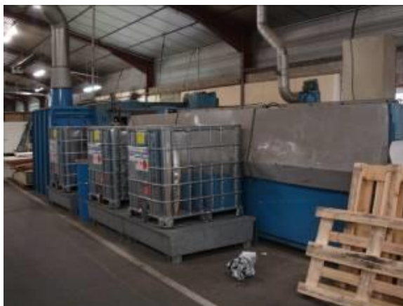
Ligne automatique pulvérisation colle solvantée
