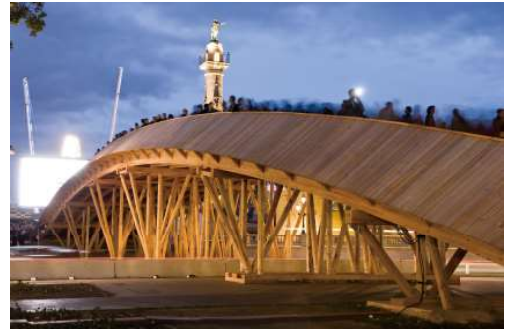
Die Brücke des Architekten Kawamata zwischen der Place des Quinconces und dem Garonne-Ufer in Bordeaux wurde mit einem Polyurethan-Klebstoff von Everad hergestellt.
