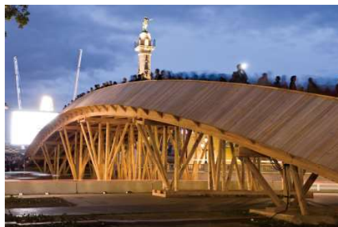
La passerelle de l'architecte Kawamata reliant les Quinconces et les quais à Bordeaux a été réalisée avec une colle polyuréthane Everad
